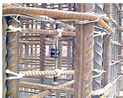
Fijación del extensómetro de cuerda vibrante sobre la armadura antes del hormigonado
