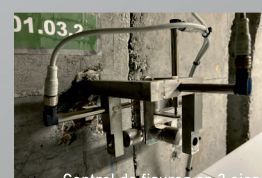
Control de fisuras en 3 ejes.
